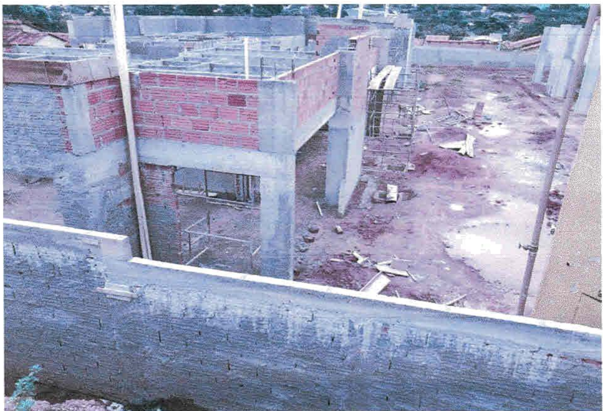
Documentos da retomada da obra em anexo.
